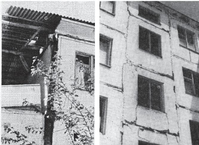
а) трещины на фасаде четырёхэтажного панельного здания; б) обвал части двухэтажного панельного здания [6]
