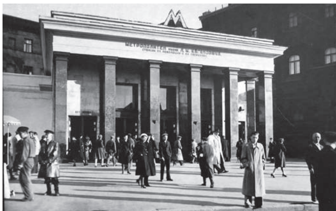
Рис. 11. Наземный вестибюль станций метрополитена «Площадь Революции» и «Площадь Свердлова». Архитектор А.Н. Душкин. 1935–1938 годы. Фото конца 1940-х годов (источник: [2, с. 167])
