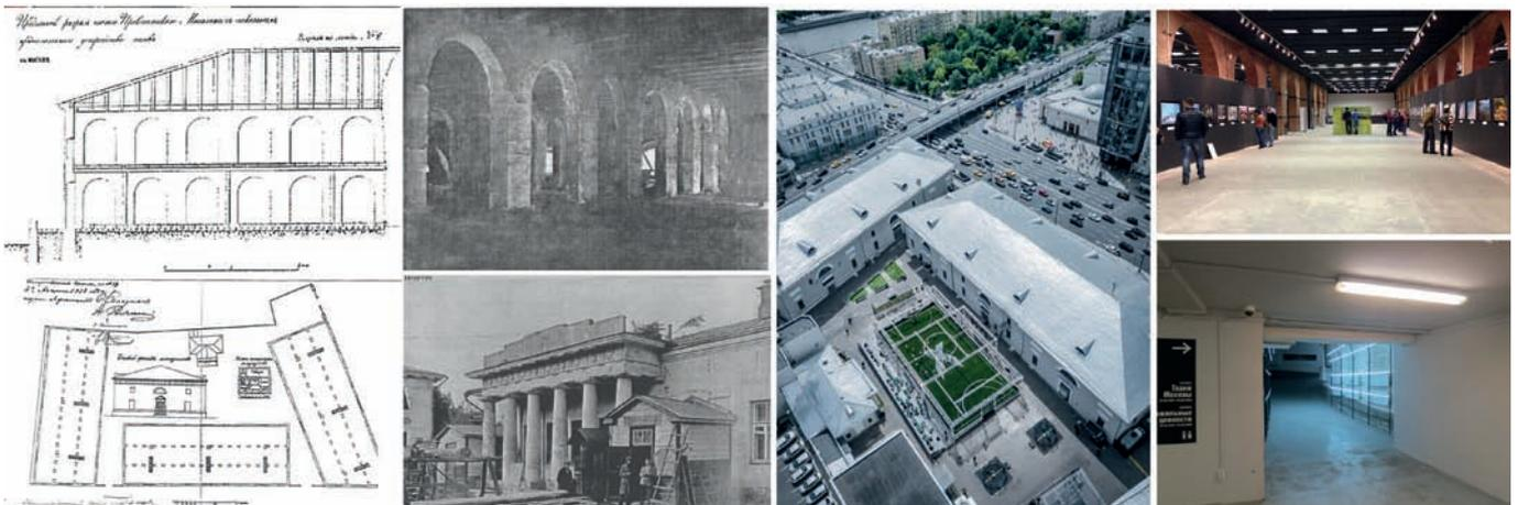
Рис. 15. Провиантские магазины (позднее – армейская автобаза) преобразованы в Музей Москвы. Слева: архивные материалы из фонда Музея архитектуры: чертежи XIX века – фрагмент продольного разреза «образцового» корпуса, схема генерального плана, натурные фотографии середины XX века – интерьер второго этажа корпуса, здание кордегардии. Справа: современное состояние: открытый двор, интерьер музейного зала, фрагмент автомобильной рампы (источник: [7, 8]; <http://mosmuseum.ru/>)
