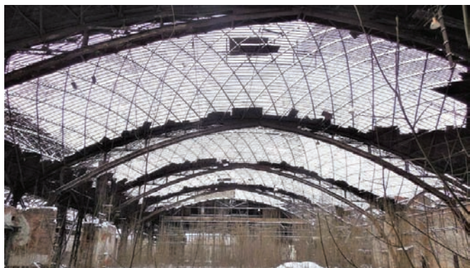
Рис. 4. Общий вид цеха в осях 1–4/А–И
