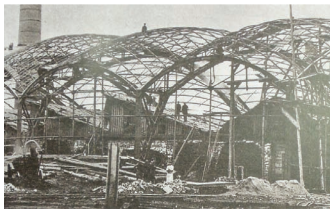
Рис. 1. Строительство листопркатного цеха («Шуховский пролёт»). 1897 год [3]
