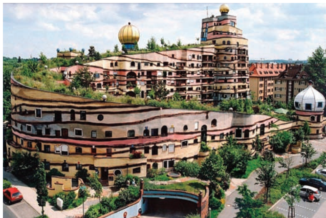
Рис. 2. Пример интенсивного типа озеленения – кровельное покрытие жилого комплекса «Вальтшпирале» (Waldspirale) в Дармштадте, Германия (источник: https://joor.me/uploads/block/2016-06-17/22/e7/JwmjqTSLMZ98iTtxo3WBKpTmAbGvbhd.jpg )
