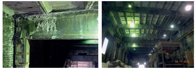
Рис. 5. Обследование серии стропильных балок. Фото с натуры авторов статьи
