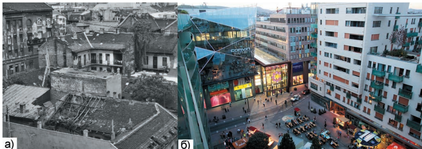
Рис. 1. Вид на реконструируемую территорию Корвин Бульвар. Будапешт. Венгрия: а) до реконструкции; б) после комплексной регенерации (источник: Rév8 Plc. Corvin-Szigony Project. – Режим доступа: http://rev8.hu/english/by-us/ )
