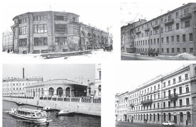
Рис. 2. Изменение фасадов зданий в ходе реконструкции (изображения верхнего ряда – до проведения работ, нижнего – обновлённые фасады): слева – Круглый рынок на Мойке, справа – улица Жуковского д. 4
