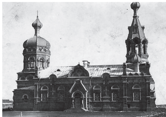
Рис. 20. Церковь Александра Невского при 154-м пехотном Дербентском полку. Крепость Карс (фото из открытых источников сети Интернет)
