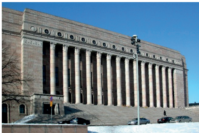
Рис. 7. Финляндия. Хельсинки. Здание парламента. Архитектор Й. Сирен. Проект 1924 года. Фото из открытых источников сети интернет
