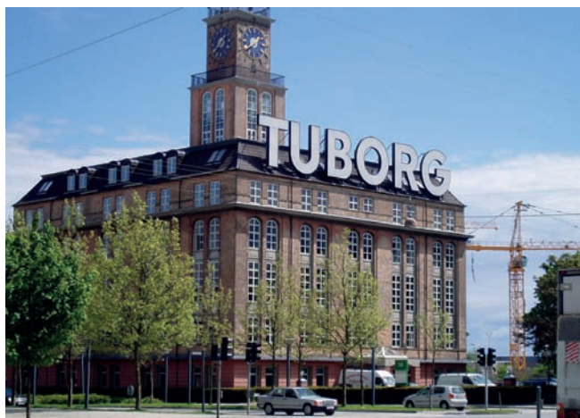
Рис. 4. Голландия. Амстердам. Завод «Туборг». Архитектор С. Рисом. 1923 год. Фото из открытых источников сети интернет
