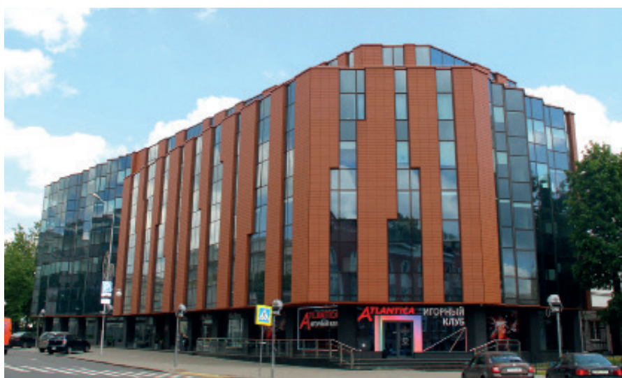
Рис. 5. Офисное здание. Архитектор В. Дражин. Начало XXI века
