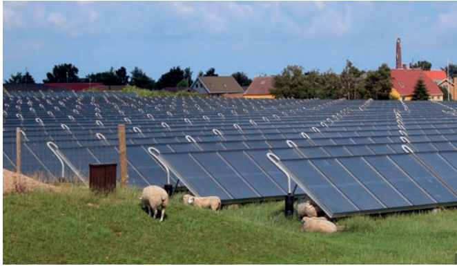
Рис. 3. Солнечная электростанция. Марстал, Дания. Солнечные батареи, имеют общую площадь 18 365 кв. м. Мощность электростанции покрывает треть энергопотребления малого города
