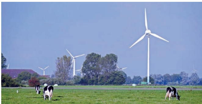
Рис. 5. Ветрогенераторы в прибрежном районе на лугу рядом с фермой. Восточная Фризия, Германия
