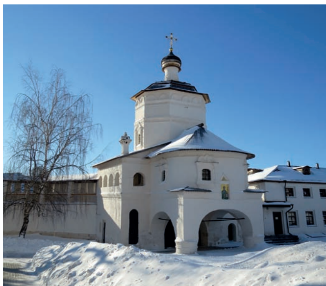
Рис. 8. Надвратная церковь Иоанна Богослова (1693–1694) старицкого Успенского монастыря. Вид с юго-востока. Фото А.М. Салимова. 2021 год
