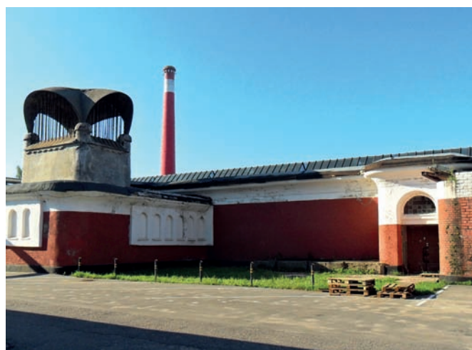
Рис. 9. Богородско-Глуховская мануфактура. Новоткацкий корпус. Архитектор А.В. Кузнецов. Село Глухово (сейчас город Ногинск). 1908 год. Слева – воздухозаборные устройства цеховой вентиляции. Современное фото А.В. Снитко
