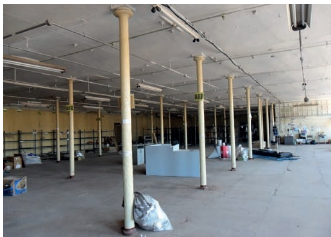
Рис. 4. Фабрика И. Гарелина. Отбельный корпус, производственный цех. Город Иваново-Вознесенск (сейчас город Иваново). 1880-е годы. Современное фото А.В. Снитко
