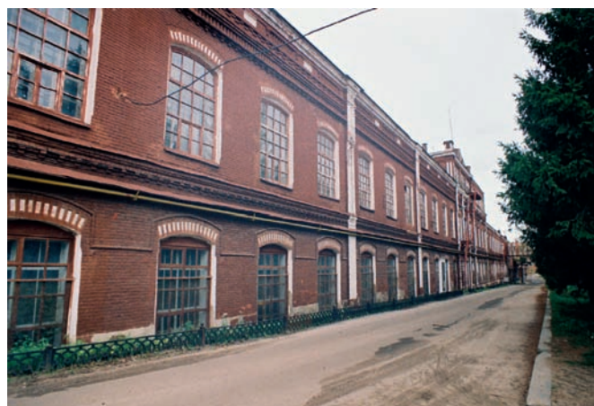
Рис. 7. Фабрика Товарищества П.Н. Грязнова. Отделочный корпус. Город Иваново-Вознесенск (сейчас город Иваново). 1893 год. Современное фото А.В. Снитко
