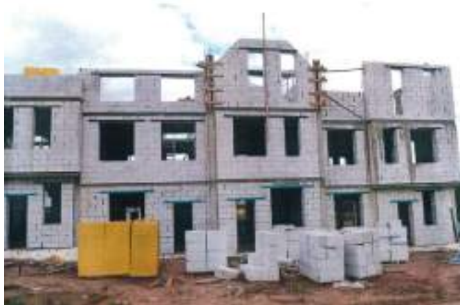
Рис. 7. Рабочий момент возведения наружных стен из газосиликатных блоков
