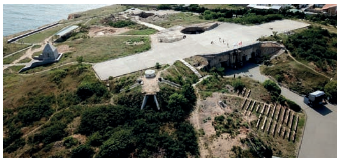
Рис. 13. Общий вид музейного комплекса «35 Береговая батарея». Фото П.В. Панухина. 2018 год
