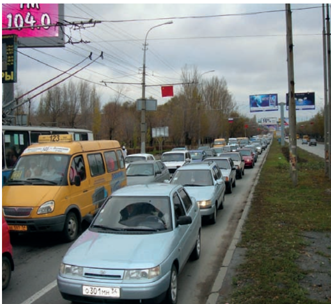
Рис. 12. Движение транспорта по проспекту им. В.И. Ленина до строительства Нулевой рокадной магистрали, Волгоград
