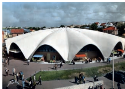
Рис. 20. Центральный рынок. Руайян, Франция. Архитекторы Симон и Мориссо (Simon et Morisseau). 1956 год: зонтичная поверхность, монолитный железобетон
