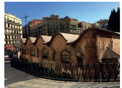
Рис. 9. Школа для детей рабочих. Испания. Архитектор А. Гауди. 1908 год: покрытие в форме синусоидального коноида. Фото Н.С. Кривошапко
