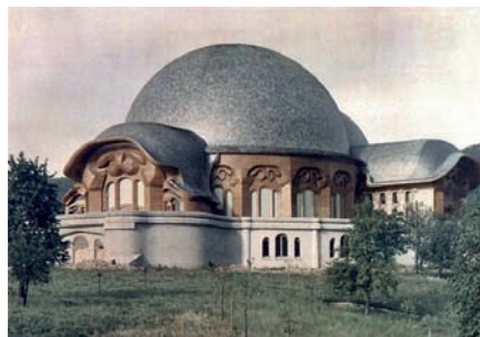
Рис. 8. Сооружение «Гётеанум-1» с полностью деревянным каркасом (сгорело в конце 1922 года). Город Дорнах, Швейцария. 1915 год. Считается первым сооружением бионической архитектуры: сферический купол
