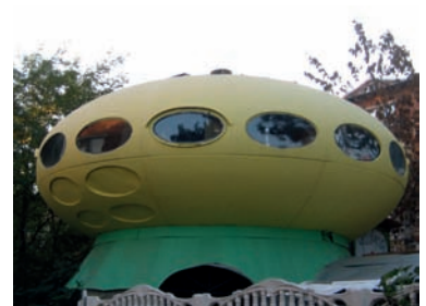
Рис. 25. Кафе «Чайная тарелка». Краснодар. 1979 год: трёхслойная оболочка, эллипсоид вращения. Фото С.Н. Кривошапко
