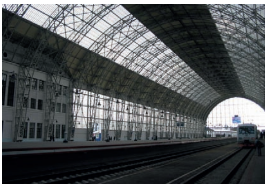
Рис. 10. Плоские металлические фермы в дебаркадере Киевского вокзала. Инженер В.Г. Шухов. 1912–1917 годы: цилиндрическая поверхность с горизонтальной осью
