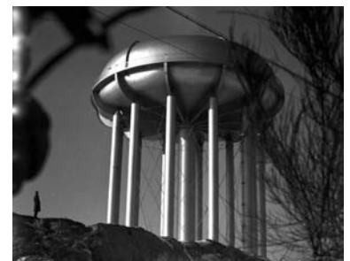
Рис. 21. Водонапорная башня (Magnolia water tank). Вашингтон, США. 1956 год: каплевидная поверхность с плоским основанием внизу
