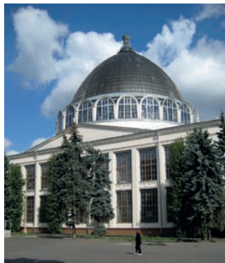
Рис. 17. Купол павильона «Машиностроение» (теперь – пав. «Космос»). Москва. Архитекторы В. Андреев, И. Таранов и Н. Быкова. 1939 год: параболоид вращения. Фото С.Н. Кривошапко
