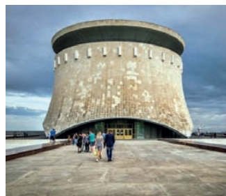
Рис. 24. Музей-панорама «Сталинградская битва». Волгоград. 1973 год: однополостный гиперболоид вращения. Фото А. Щербака
