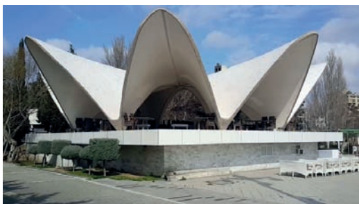
Рис. 19. Ресторан «Жемчужина». Баку, Азербайджан. Архитекторы В. Шульгин, Р. Шарифов. 1962 год: зонтичная поверхность из восьми фрагментов гипара, железобетон
