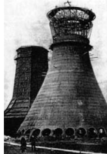
Рис. 12. Первая железобетонная градирня. Город Херлен, Нидерланды. Инженер Ф. ван Итерсон. 1918 год
