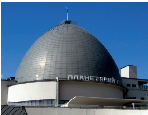
Рис. 16. Железобетонный купол Московского планетария диаметром 27 м и толщиной около 7 см. Архитекторы М.О. Бари и М.И. Синявский. 1929 год: параболоид вращения. Фото И.А. Мамиевой
