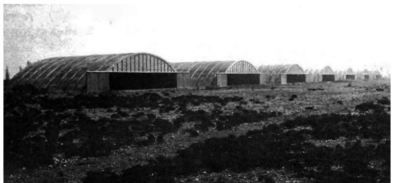
Рис. 11. Бетонные параболические цилиндрические ангары. Город Истр, Франция. Архитектор Э. Фрейссине. 1917 год
