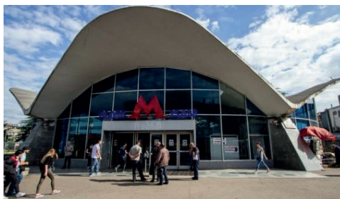
Рис. 27. Станция метро «Исани». Тбилиси, Грузия. Архитекторы Г. Модзманишвили, Н. Ломсадзе. 1971 год: зонтичная поверхность, покрытие из монолитного железобетона толщиной 6–10 см, размеры в плане 30×40 м
