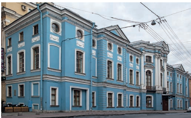
Рис. 3 6 . Дворец И.И. Шувалова (Санкт-Петербург, Итальянская ул., 25, Малая Садовая ул., 1). Архитектор С.И. Чевакинский. 1753–1755 годы
