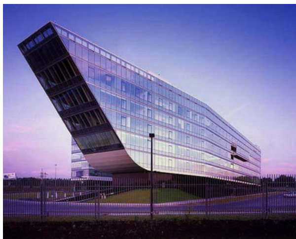
Рис. 5. Офисное здание «Аэрофлота». Москва (б. деревня Мелькисарово). 2006–2009 годы. Архитектор В. Плоткин
