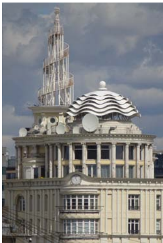
Рис. 2. Жилой дом «Патриарх». Фрагмент. Москва. Архитекторы С. Ткаченко, О. Дубровский. 2000 год. Фото Н.В. Касьянова
