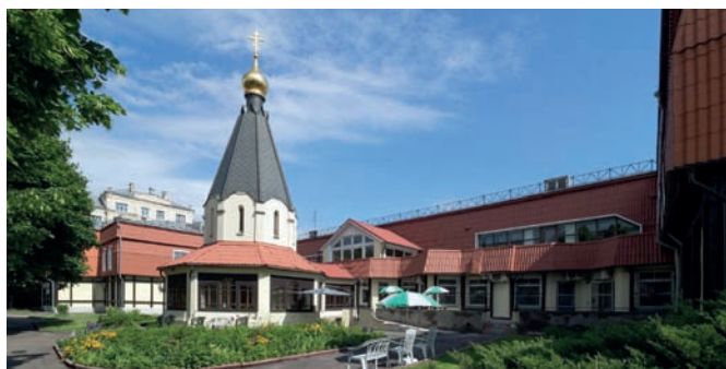
Рис. 10. Архитектурный облик Первого хосписа. Москва
