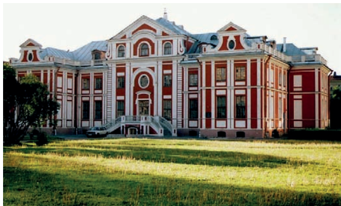
Рис. 1 1 . Кикины палаты в районе Смольного двора. Современное фото
