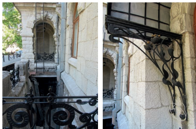
Рис. 9. Дом Фредерикса. Фото И. Слюньковой. 2018 год: а) ров-прямок и мостики входа; б) козырёк над входом
