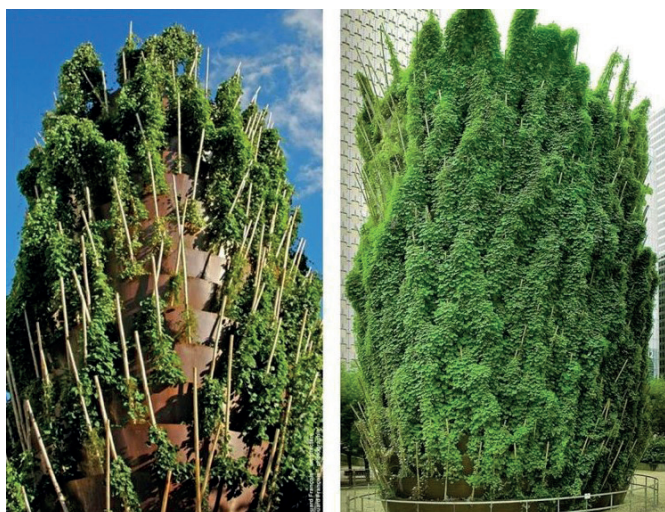
Рис. 1 3 . Вертикальное озеленение вентиляционной шахты в квартале Ла Дефас в Париже. Архитектор Э. Франсуа
