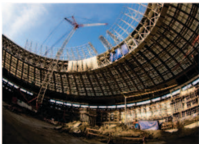
Рис. 2. Процесс устройства «наращиваемой» консольной части кровли над трибунами
