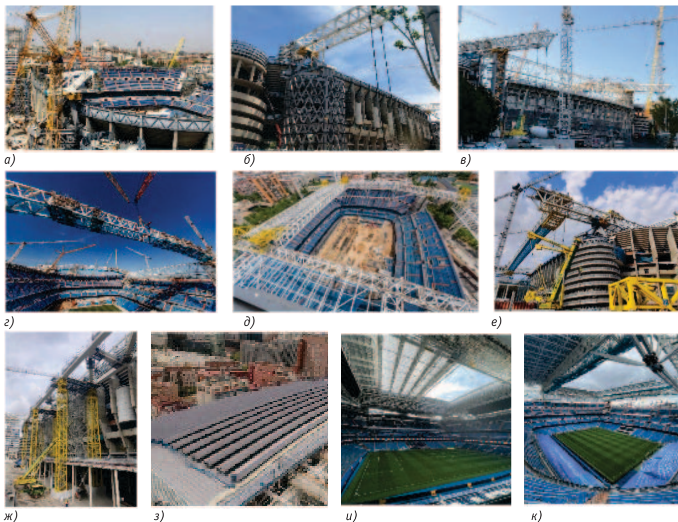
Рис. 21. Возведение кровли стадиона «Сантьяго Бернабеу» в процессе реконструкции: а) монтаж первых сегментов северной и южной ферм конструкции крыши с опорой на новые башни В и С; б) монтаж внешних секций южных и северных ферм с устройством противовесов с креплением к земле для их стабилизации; в) вид на стадион с восточной стороны при монтаже северной и южной ферм; г) процесс «замыкания» южной фермы; д) перенос смонтированного модуля крыши с помощью передвижных тележек с западной на восточную сторону; е) перемещение в проектное положение западной фермы; ж) монтаж «коронной» балки по замкнутому внешнему периметру для расширения внутренних коридоров стадиона; з) устройство верхнего слоя кровельного покрытия – алюминиевой оболочки; и) конструкция раздвижной крыши стадиона (вид изнутри); к) вид крыши стадиона со стороны посадочных мест после реконструкции
