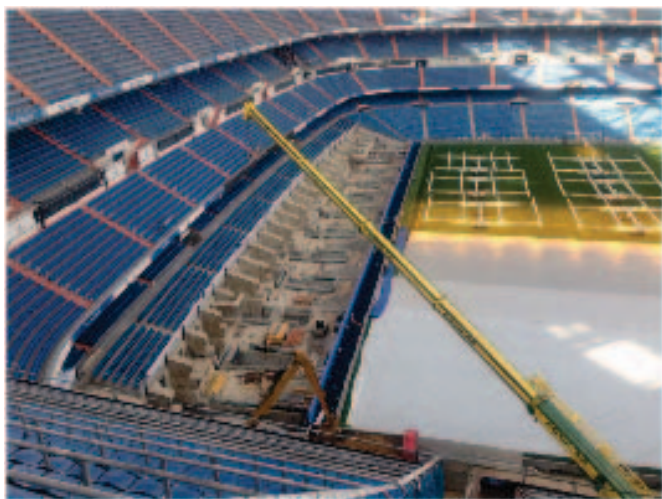
Рис. 33. Западные трибуны: а) процесс реконструкции; б) возведение западных трибун нижнего сектора консольного типа
