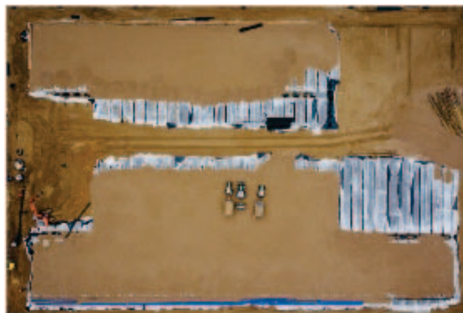
Рис. 6. Процесс устройства многослойного инженерного «пирога» из систем дренажа, аэрации, подогрева и мониторинга агротехнических характеристик для обслуживания футбольного поля
