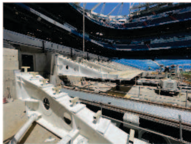
Рис. 33. Западные трибуны: а) процесс реконструкции; б) возведение западных трибун нижнего сектора консольного типа
