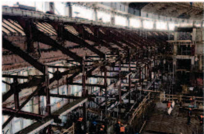
Рис. 8. Укрепление фасадной стены стадиона при демонтаже и устройстве новой чаши (фрагмент)
