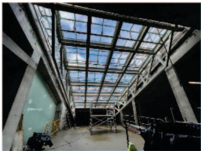
Рис. 30. Устройство каркаса складной трибуны на восточной стороне с внутреннего пространства
