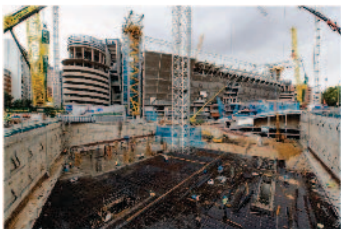
Рис. 27. Монтаж подземной парковки на месте демонтируемого торгового центра
