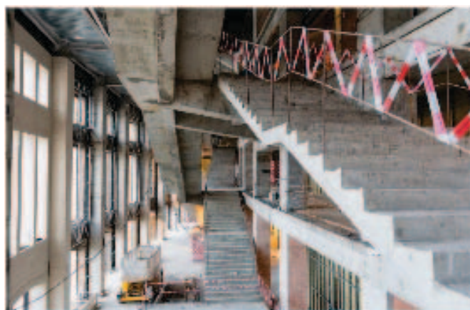
Рис. 12. Устройство каскадных пешеходных лестниц
