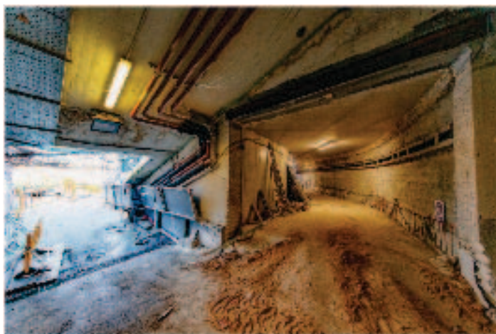
Рис. 32. Логистический туннель: а) устройство подвода к футбольному полю; б) прокладка коммуникаций
