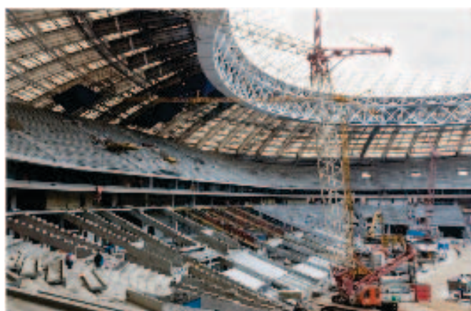
Рис. 11. Монтаж сборного железобетонного покрытия нижнего яруса трибун
