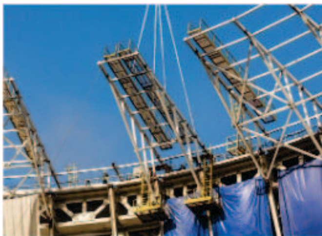
Рис. 3. Сварное соединение блока козырька с внутренним контуром существующей конструкции крыши
