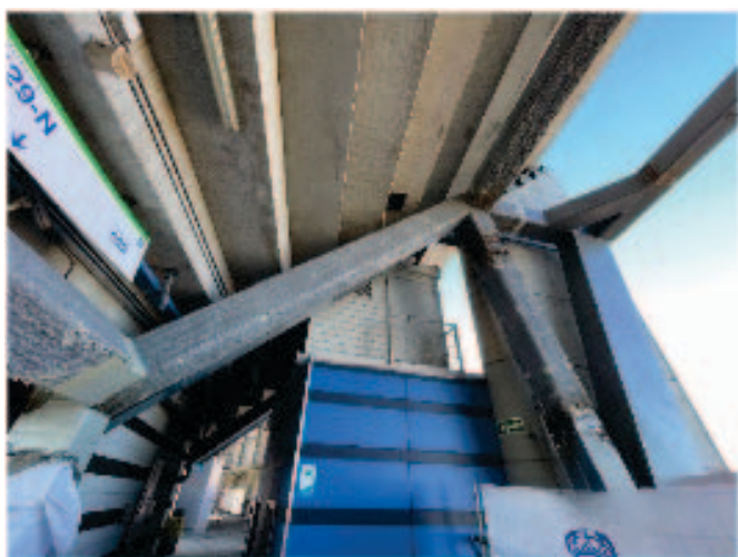
Рис. 24. Усиление ребер северного и южного торца стадиона
