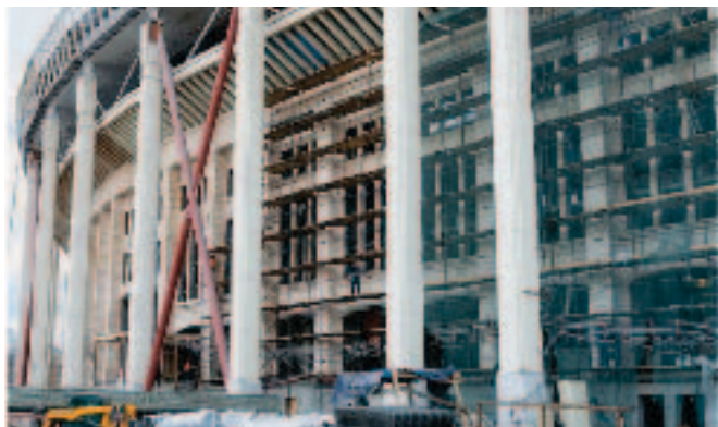
Рис. 1 3 . Процесс ведения реставрационных работ фасадной стены стадиона БСА «Лужники»
