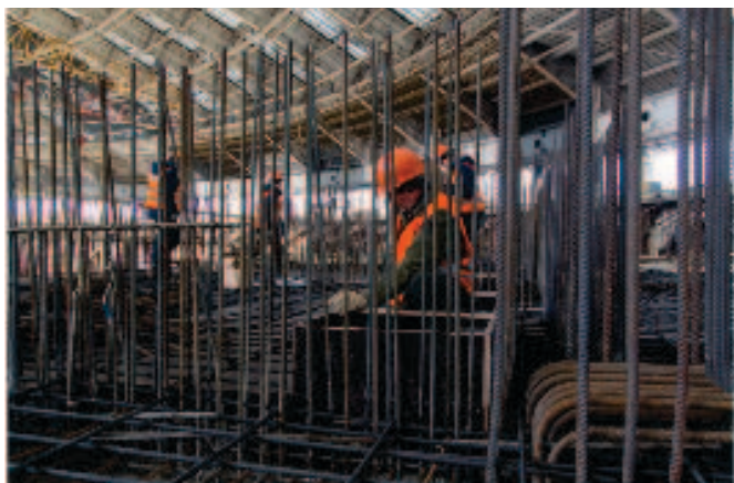
Рис. 10. Монтаж арматуры при устройстве чаши стадиона
