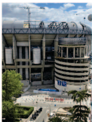
Рис. 19. Процесс демонтажа старой крыши
