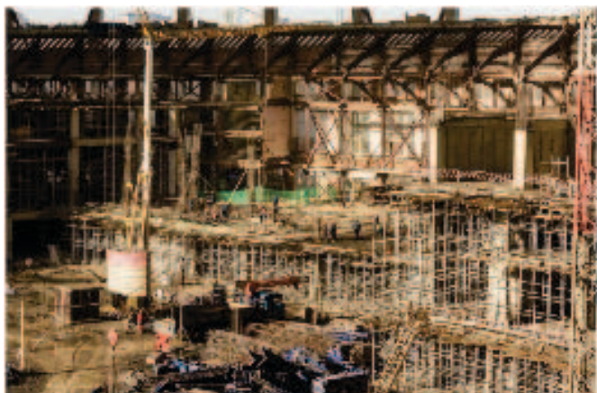
Рис. 9. Процесс устройства железобетонного каркаса трибун
