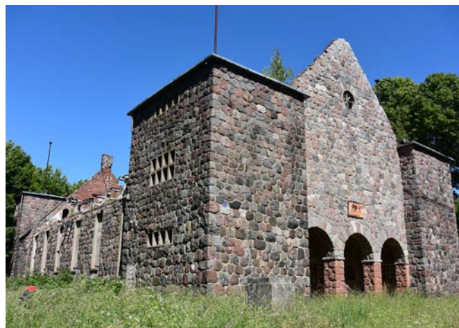
Неман / бывш. Рагнит. Здание бывшего «партайбурга». Арх. и дата не установлены. Фото И.В. Белинцевой
