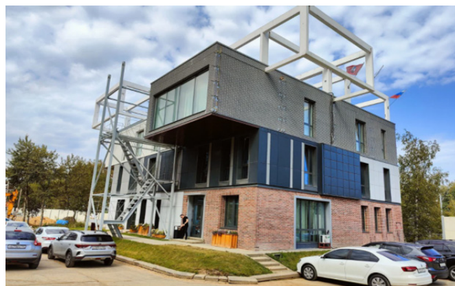
Рис. 4. Пример компоновки здания из крупногабаритных железобетонных модулей
