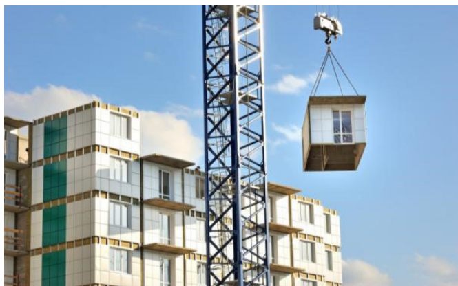
Рис. 3. Монтаж железобетонного модуля типа «колпак»
