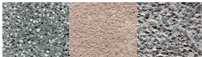
Рис. 1. Примеры вариантов терразитовой штукатурки
