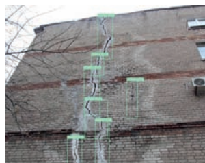
Рис. 1. Примеры дефектов на фасадах кирпичных зданий. Фото автора статьи
