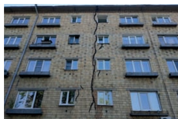
Рис. 1. Примеры дефектов на фасадах кирпичных зданий. Фото автора статьи
