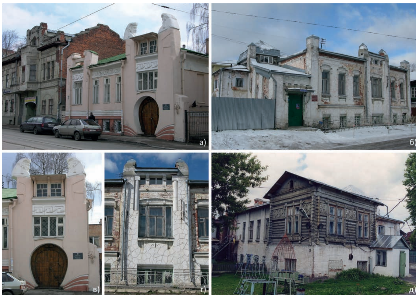
Рис. 7. Дом А.И. Троицкого. Нижний Новгород, ул. Пискунова, 35. Фото А.В. Лисицыной 2006 года: а) общий вид; б) дом А.М. Тербина. Фрагмент фасада. Павлово, ул. Крупской, 10. Фото А.В. Лисицыной 2014 года: в) общий вид; г) фрагмент фасада; д) вид со стороны двора
