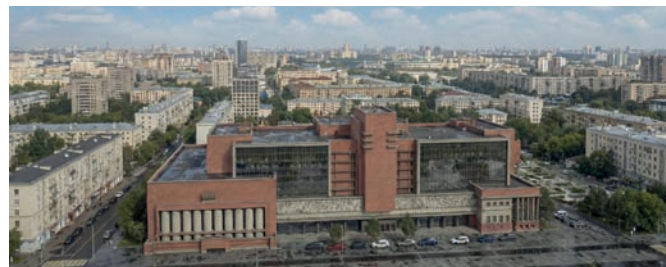
Рис. 3. ДК им. Кирова. Проект: а) промежуточный вариант; б) Панорамный вид. 3D-визуализация выполнена Штиглиц М.С., Аbruковой Е.Р.
