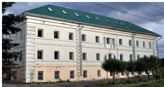
Рис. 8. Здание главной конторы Златоустовского завода. Начало XXI века
