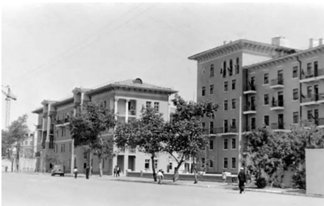
Рис. 17. Жилые дома № 8 и № 10 по улице Мира. 1952 год. Архитектор С. Блументаль Фото Л. Наймана
