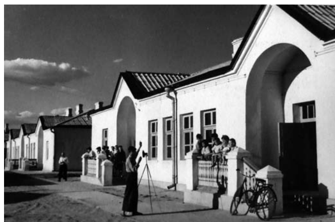
Рис. 7. Сталинград. 16-квартирные шлакоблочные жилые дома завода «Красный Октябрь» (источник: [5, с. 136])
