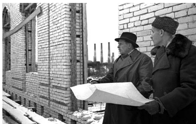
Рис. 12. Главный архитектор Сталинграда В. Симбирцев и архитектор К. Скрипичин на строительной площадке в Краснооктябрьском районе (источник: РГАКФД. Фотофонды. № 0-344780)
