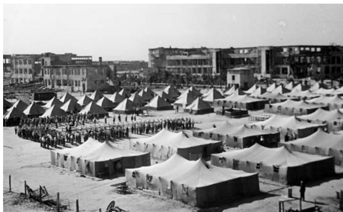
Рис. 2 1 . Общий вид временного лагеря рабочих-строителей, прибывших на восстановление Сталинграда. 1943 год. Фото Косицина (источник: РГАНИ)
