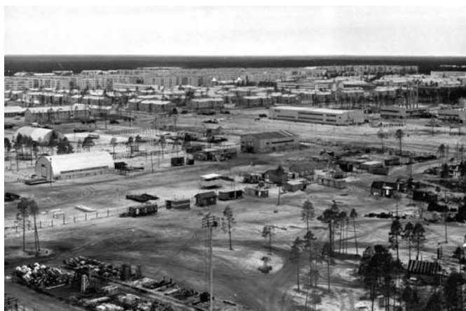
Рис. 3. Начало строительства посёлка Муравленковский (источник: Муниципальный архив Администрации города Муравленко. 1980-е гг. Ф. Ф-1. Оп. 2. Д. 537)
