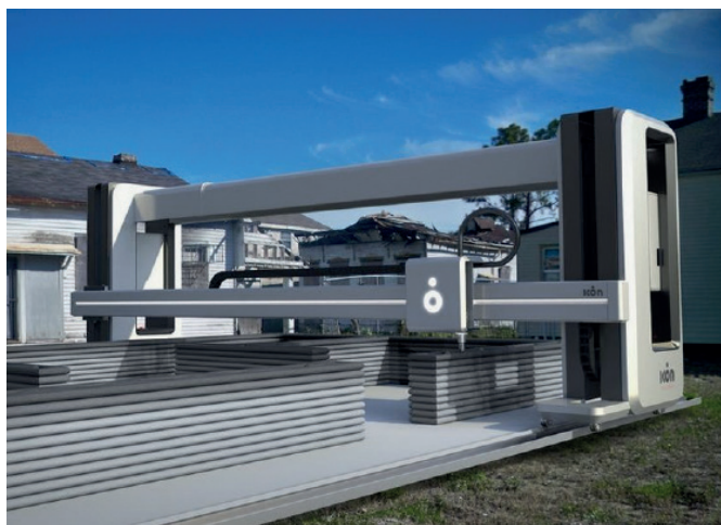
Рис. 2. Строительный 3D-принтер на объекте. Пример реализации аддитивной технологии в жилищном строительстве
