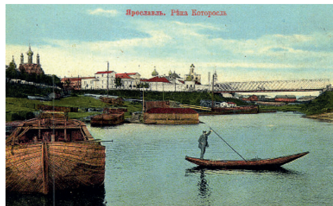
Рис. 5. Мост через реку Которосль. Фото начала XX века
