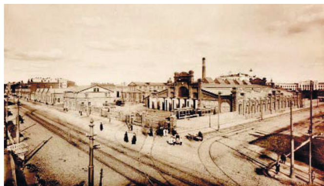
Рис. 2. Конно-трамвайный парк. Историческая фотография (источник: Альбом зданий, принадлежащих Московскому городскому общественному управлению. Москва : Фототипия П.П. Павлова, 220 с.)
