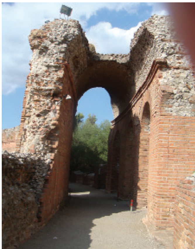
Рис. 19. Театр в Таормине. Римская надстройка театрона – верхние места для зрителей подняты на субструкции
