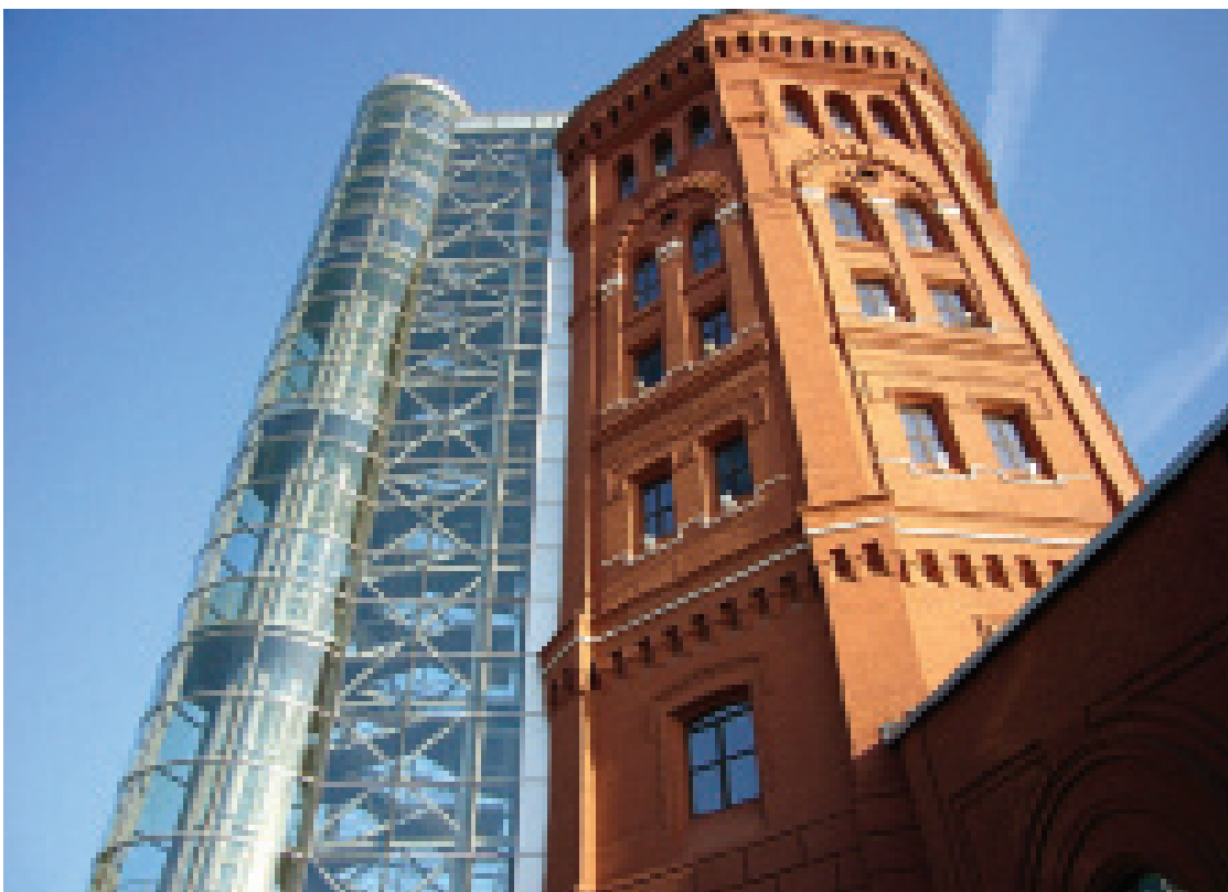
Рис. 4. Реставрация и реконструкция водонапорной башни, построенной в 1859–1861 годах. Преобразована в Музей воды. Санкт-Петербург. Архитектор Е.Подгорнов. 2003
