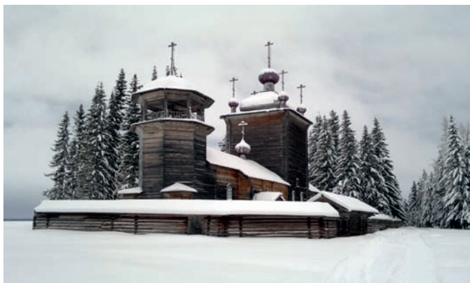
Рис. 1. Комплекс Ильинско-Водлозерского погоста после реставрации. Фото автора. 2015 год
