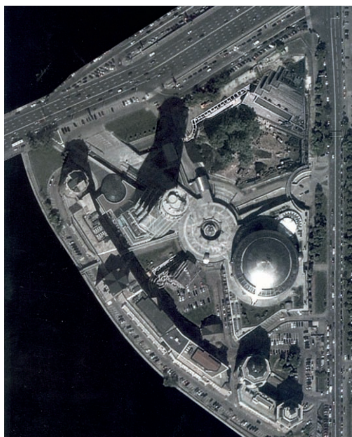
Российский культурный центр, 1995–2006 годы. Космическая съемка 2005 года. Архитекторы: Ю.Гнедовский, В.Красильников, Д.Солопов, М.Гаврилова, С.Гнедовский при участии И.Захарова, Инженер С.Белов
