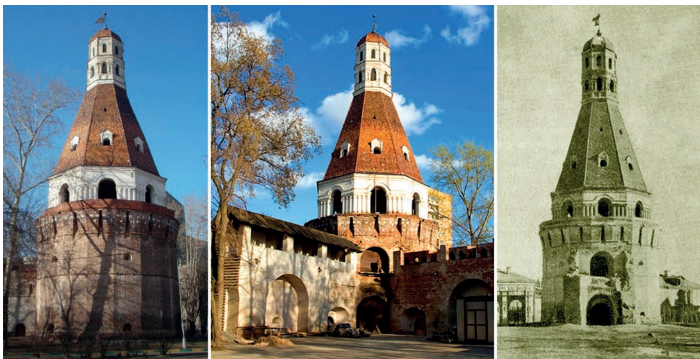
Рис. 7. Солевая, или Вылазная башня. Вид снаружи с юга. Вид с северо-запада с построенными заново участками примыкающих крепостных стен. Вид с северо-запада после разборки примыкающих стен
