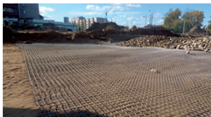
Рис. 2. Строительство и ремонт автомобильных дорог с использованием ГСМ
