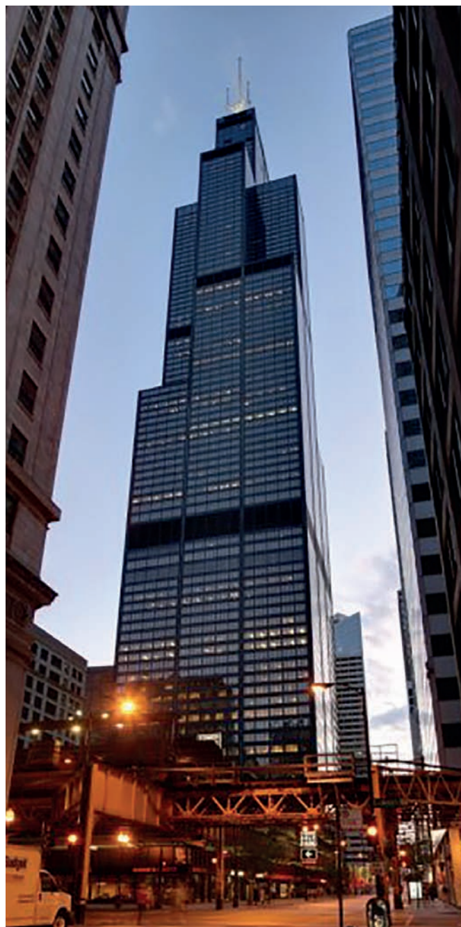
Рис. 14. Небоскрёб Сирс-тауэр в Чикаго. Архитектор Б. Грэм. 1973 год
