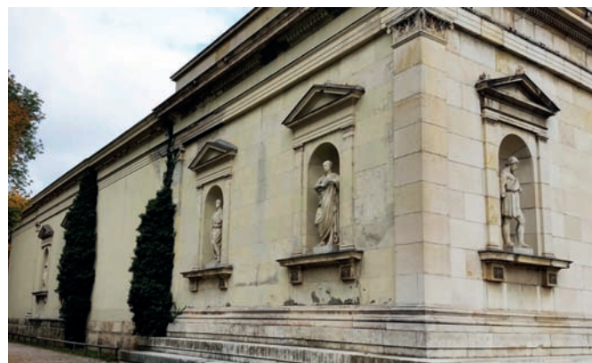
Рис. 8. Западный и южный (главный) фасады здания Глип-тотеки с украшающими их скульптурами в полукруглых нишах. Вид с юго-западной стороны. Фото авторов, октябрь 2015 года
