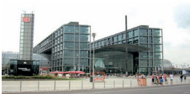
Центральный вокзал в Берлине. Архитекторы фон Геркан, Марг и Партнеры. 1995–2006 годы (к главе 11)
