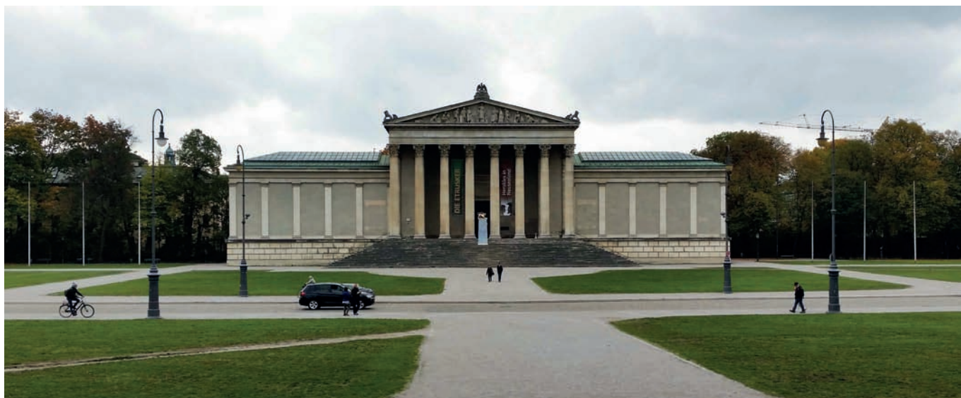
Рис. 9. Главный фасад здания Античного собрания. Вид с северной стороны. Фото авторов, октябрь 2015 год
