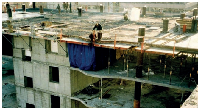
Рис. 9. Рабочий момент бетонирования колонн, армирования и бетонирования плиты перекрытия
