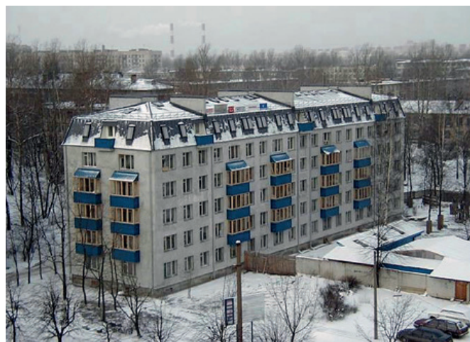
Рис. 1. «Пятиэтажка» в которой был проведен капитальный ремонт, «компенсированный» надстройкой одноуровневой мансарды
