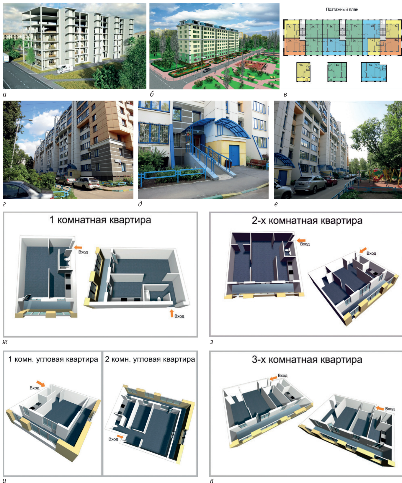
Рис. 2. Реконструкция дома с надстройкой: Химкинский бульвар, дом 4.
