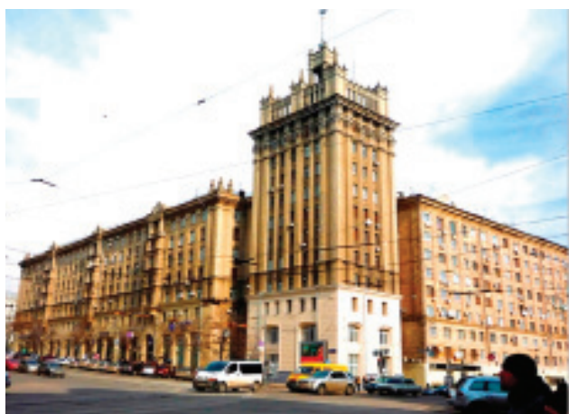
Рис. 17. Жилой дом с магазином «Книжный мир» по Московскому проспекту на месте разрушенного квартала малоэтажных зданий. Архитектор П.И.Арешкин. 1954–1967
