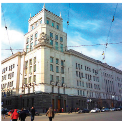
Рис. 14. Здание Харьковского Горсовета и его послевоенная реконструкция. Архитекторы В.Н.Пети, В.К.Троценко, В.И.Пушкарёв (1931–1932), В.П.Костенко, Ю.Чеботарев (1947–1954)
