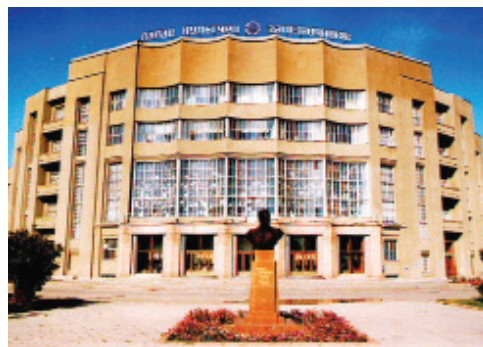
Рис. 13. Дворец культуры железнодорожников на улице Котлова. Архитектор А.Дмитриев при участии В.Вержужского. 1928–1933
