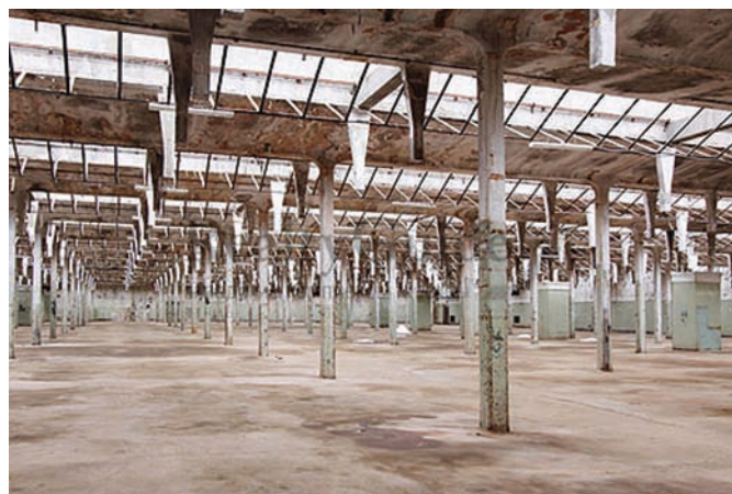
Рис. 2. Богородск (ныне Ногинск). Новоткацкий корпус Богородско-Глуховской мануфактуры, 1907, гражданский инженер А.В.Кузнецов. Интерьер цеха
