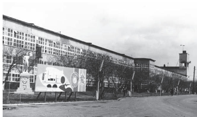
Рис. 4. Иваново-Вознесенск (ныне Иваново). Прядильный корпус фабрики «Красная Талка», 1929, архитекторы И.С.Николаев и Б.В.Гладков. Справа – водонапорная башня
