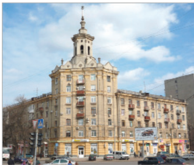
Рис. 19. Жилой дом с кинотеатром «Родина» на углу улиц Плехановской и Кирова. Архитектор А.Г.Крыкин. 1954
