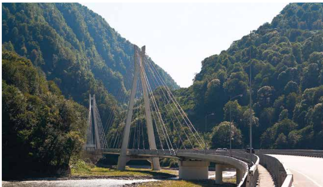
Рис. 5. Совмещенная железная и автомобильная дорога Адлер – Красная Поляна
