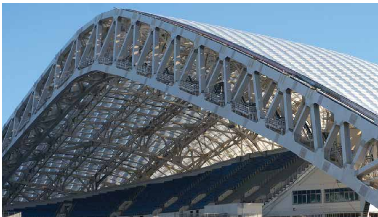
Конструкция главного стадиона «Фишт»
