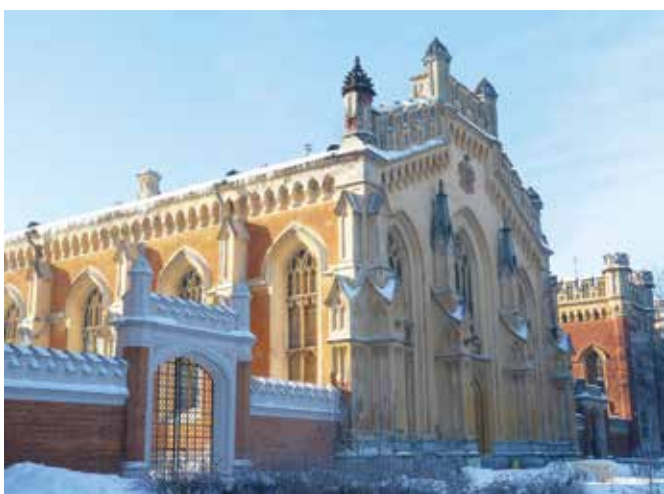
Рис. 8. Конюшни в Петергофе. Архитектор Н.Л.Бенуа, 1847 год. Общий вид. Манеж
