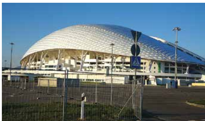
Главный стадион «Фишт» – место открытия и закрытия Олимпиады – переоборудуется в футбольный стадион
