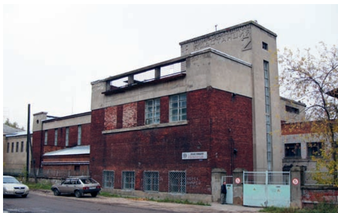
Рис. 8. Город Иваново. Трансформаторная подстанция № 2 ИвГРЭС. Вид с улицы Зверева
