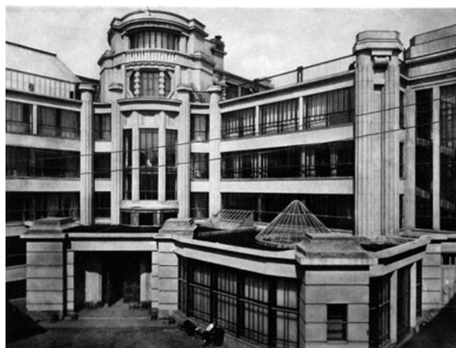
Общий вид корпуса мастерских Строгановского училища. Фото 1915 года
