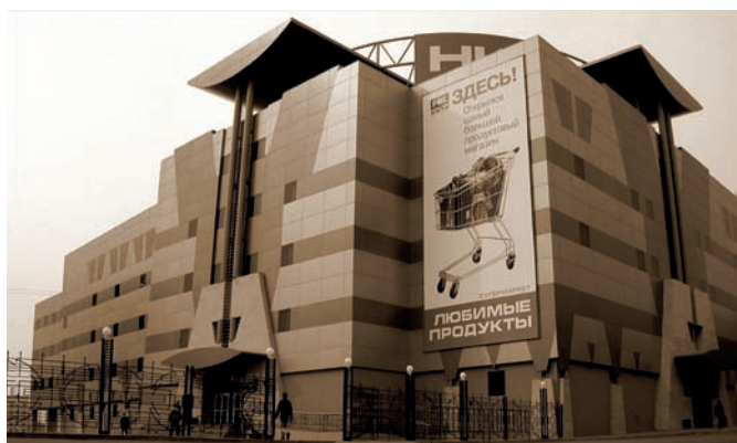
Рис. 9. Торговый комплекс НК-Сити в Хабаровске. Архитекторы В.Н. Белошниченко, Г.Ю. Бычкова, А.П. Редькин
