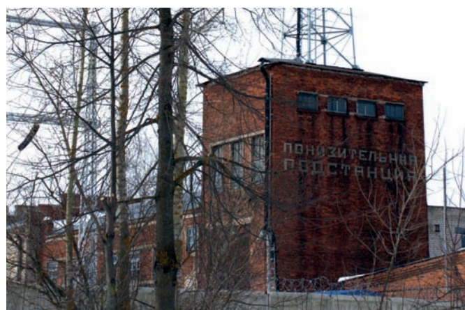
Рис. 15. Город Родники Ивановской области. Понизительная подстанция ИвГРЭС
