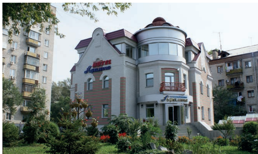
Рис. 16. Гостиница «Афалина» на Амурском бульваре в Хабаровске. Архитектор А.П. Редькин
