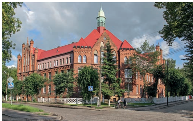
Здание школы-интерната. Главный фасад строго симметричен
