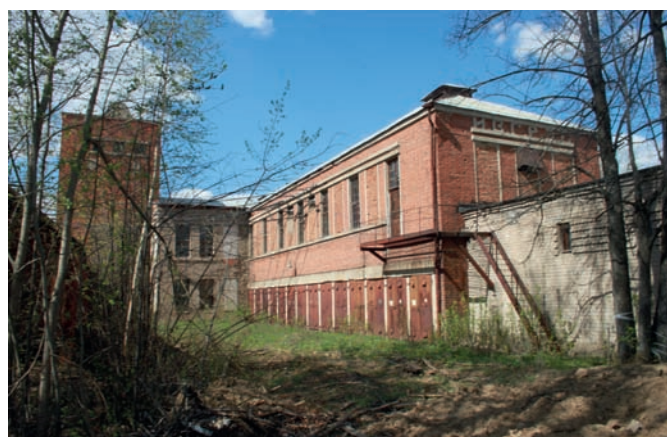
Рис. 14. Город Вичуга Ивановской области. Понизительная подстанция ИвГРЭС
