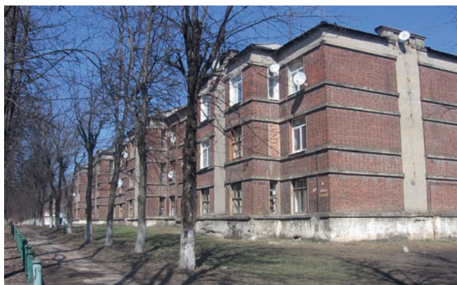
Рис. 20. Город Комсомольск Ивановской области. Жилой дом соцгородка ИвГРЭС
