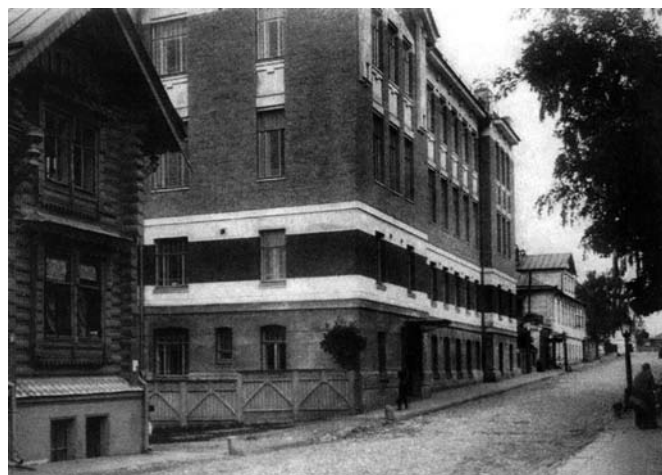
Седьмой Ростовский переулок в Москве. Слева типичный деревянный дом застройки вне Садового кольца. Дореволюционный снимок. К 1960-м годам такие дома практически по всей Москве снесли
