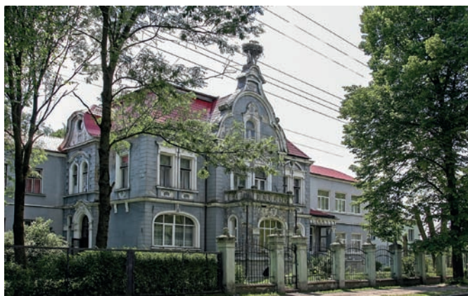
Северный и восточный фасады бывшей виллы Лазер. 2010
