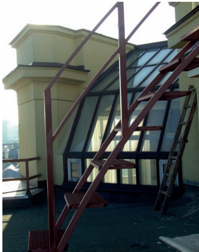
Кузнецовский корпус МАрХИ. Фонарь бывшей художественной студии Строгановского училища после реконструкции
