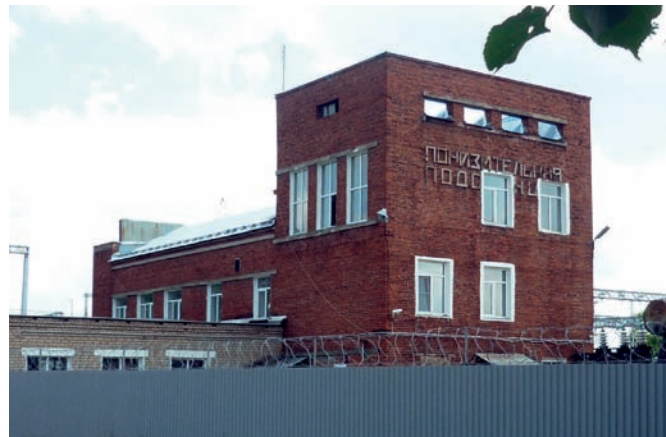
Рис. 16. Город Тейково Ивановской области. Понизительная подстанция ИвГРЭС
