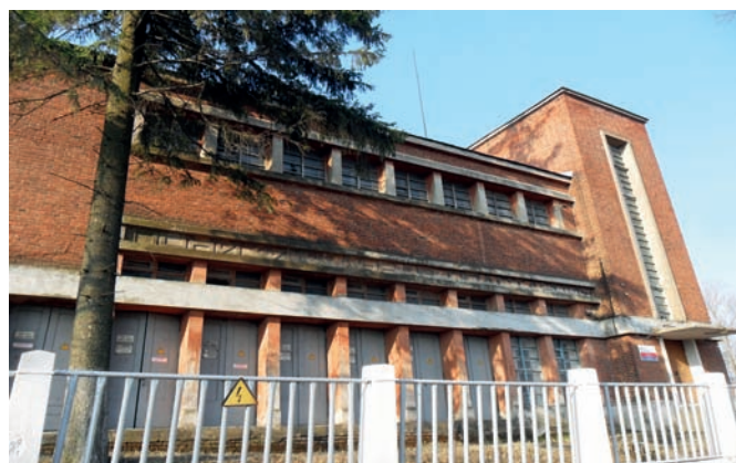
Рис. 9, 10. Город Кохма Ивановской области. Понижительная подстанция ИвГРЭС
