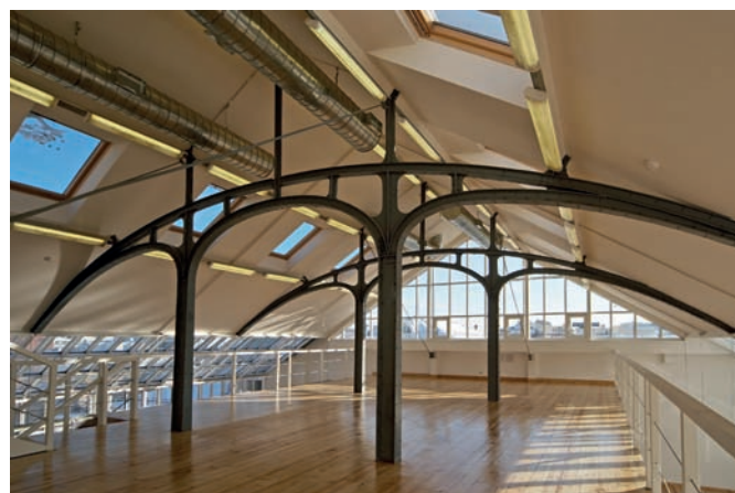
Антресольное пространство Шуховского зала. Исторические конструкции выкрашены в серый цвет
