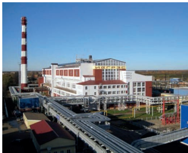
Рис. 5. Город Комсомольск Ивановской области. Ивановская ГРЭС
