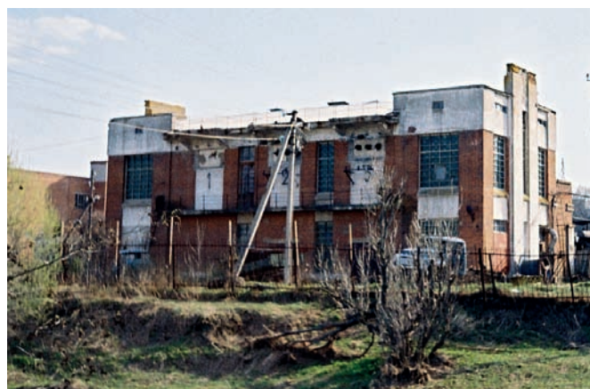
Рис. 12. Село Лежнево Ивановской области. Понизительная подстанция ИвГРЭС. Вид со стороны реки Ухтохмы
