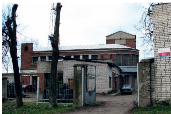
Рис. 13. Город Шуя Ивановской области. Понизительная подстанция ИвГРЭС
