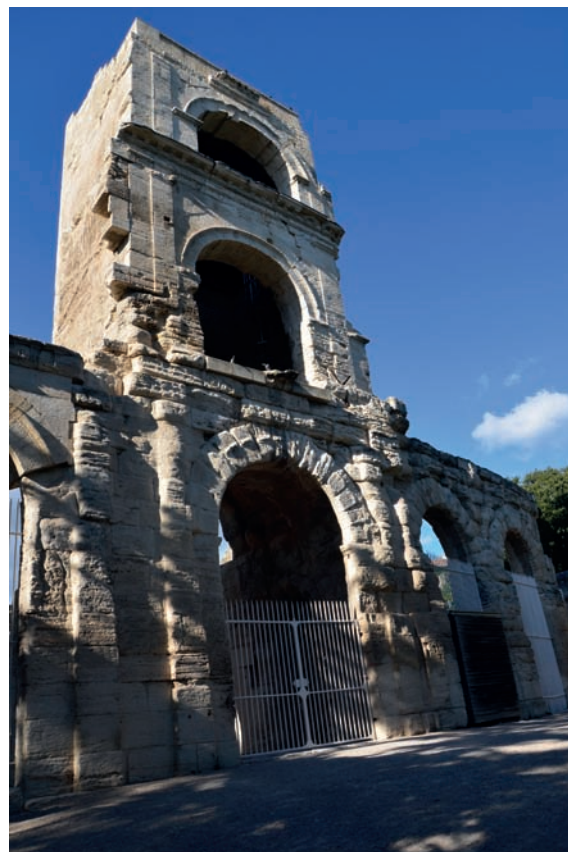
Рис. 16. Фрагмент фасада театра в Арле. Слицевой стороны все средневековые переделки были убраны в процессе реставрации
