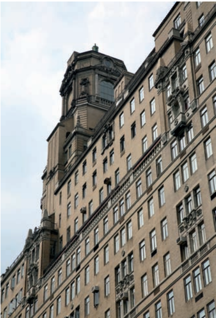
Рис. 8. Жилой дом Бересфорд в Нью-Йорке. Архитектор Э.Рот, 1929
