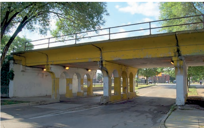
Рис. 12. Современное состояние территории Блумингдейл-Трейл. Виадук
