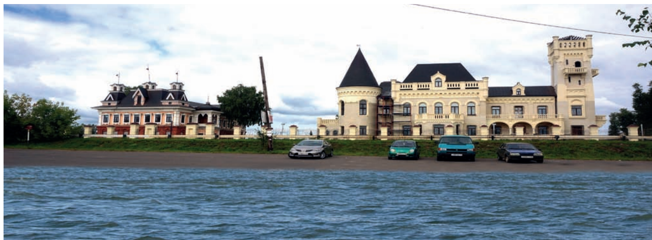
Набережная Волги в Красном Профинтерне. Справа «дом-замок» Н.А.Понизовкина, 1912–1914.
