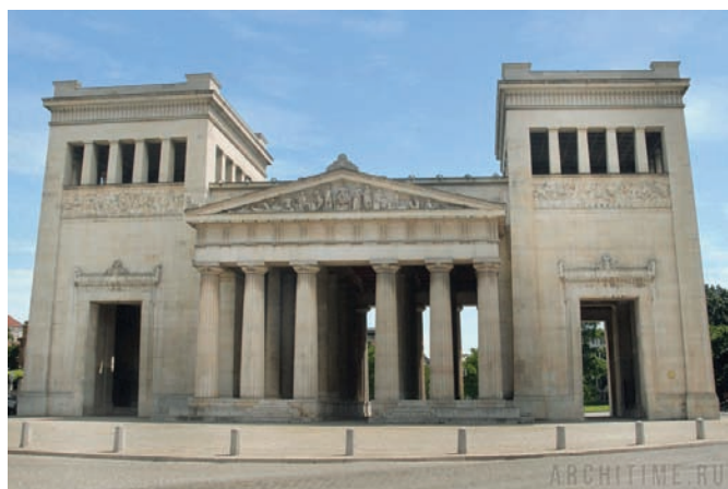
Рис. 2. Пропилеи в Мюнхене. Архитектор Лео фон Кленце, 1842–1863
