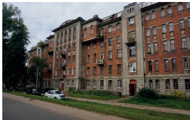
40-квартирный дом для рабочих и служащих Н.А.Понизовкина Строитель — гражданский инженер Н.Ю.Лермонтов. Фото автора. 2015
