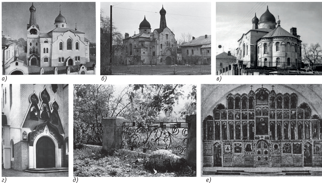
Рис. 2. Церковь Успения и Покрова Богоматери. Москва, Малый Гавриков переулок, 29: а) фасад с южной стороны; б) с северо-западной стороны; в) с юго-восточной стороны; г) крыльцо; д) фрагмент ограды; е) иконостас
