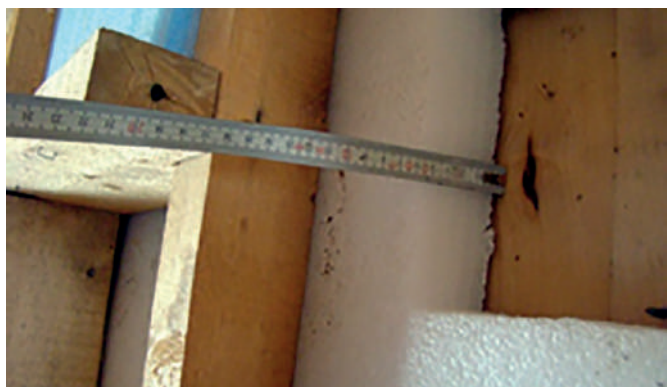
Рис. 6. Место обора проб и фрагмента соснового бруса в наружной стене здания
