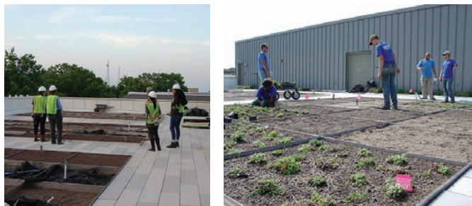
Рис. 4. Устройство экспериментальной «зелёной» крыши по разработкам проектного бюро «APDesign» (источник: https://www.k-state.edu/greenroofs/apdesign.html )
