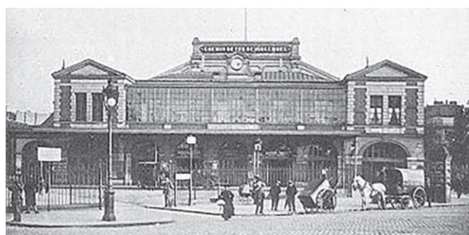
Рис. 12. Вокзал Бастилия, снесённый перед строительством театра
