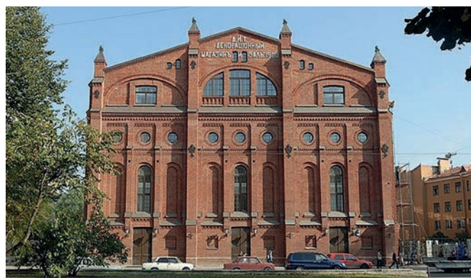
Рис. 11. Сохранившийся фасад склада декораций Мариинского театра по улице Писарева. Архитектор В.А. Шретер. 1900 год
