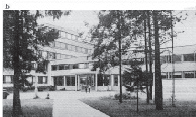
Рис. 7. Ногинский научный центр. Город Черноголовка Московской области: А – здание административно-общественного центра; Б – Институт физики твёрдого тела (фрагмент)
