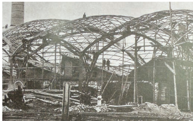
Рис. 1. Строительство листопркатного цеха («Шуховский пролёт»). 1897 год [3]
