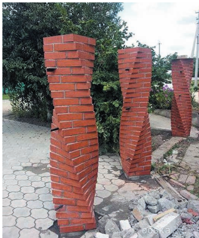
Рис. 20. Закрученные кирпичные столбы, каждая из четырёх граней которого представляет собой псевдоразвертывающийся геликоид
