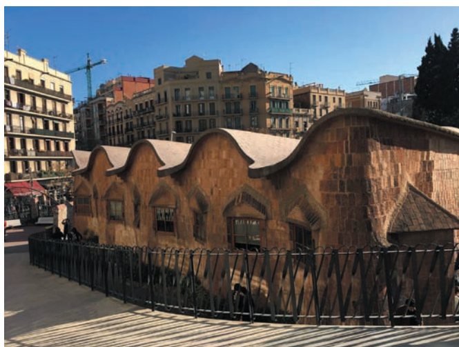
Рис. 11. Школа с коноидальной крышей. Барселона, Испания: а) стены школы – из кирпича без облицовки; б) металлические балки совпадают с прямыми образующими коноида. Фото И.А. Мамиевой
