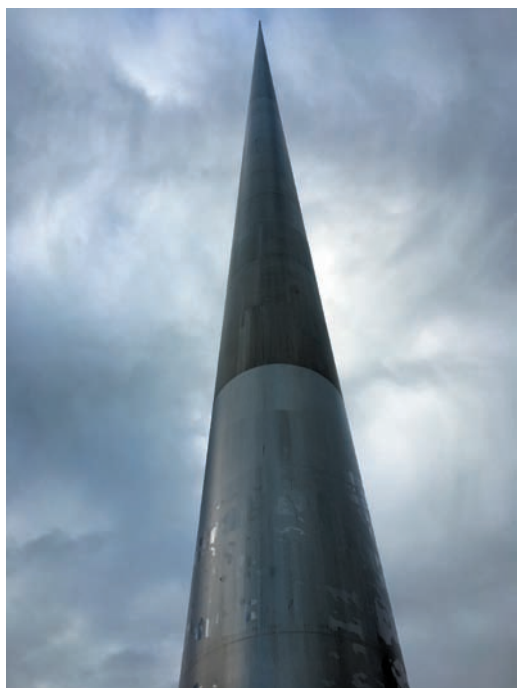
Рис. 2. Стела из нержавеющей стали высотой 121,2 м. Дублин, Ирландия. Архитектор Я. Ричи. Фото И.А. Мамиевой
