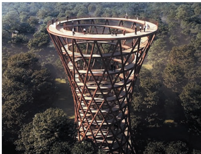
Рис. 24. Винтовая смотровая башня в Дании. Студия «ЭФ-ФЕКТ» («EFFEKT»). Дания. Конструкция с направляющей спиралью на однополостном гиперboloиде вращения. Дания (источник: https://i.pinimg.com/originals/93/27/44/9327442fed1b5b63cf9301387c00f5b9.jpg )
