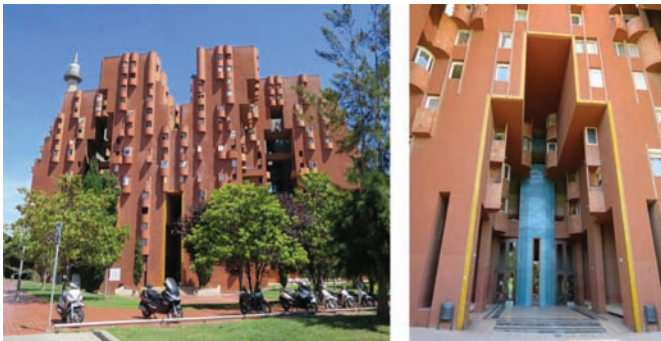
Рис. 17. Жилой комплекс «Уолден 7» («Waldon 7»). Барселона, Испания. Архитектор Рикардо Бофилл и группа Тальер. 1975 год. Фото А.Л.Гельфонд
