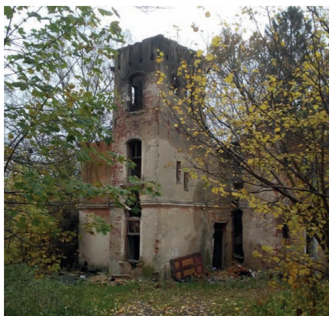
Рис. 10. Выявленный объект культурного наследия «Вилла» (Заречный проезд, 5) Фото В.И. Пустовгарова. 2019 год
