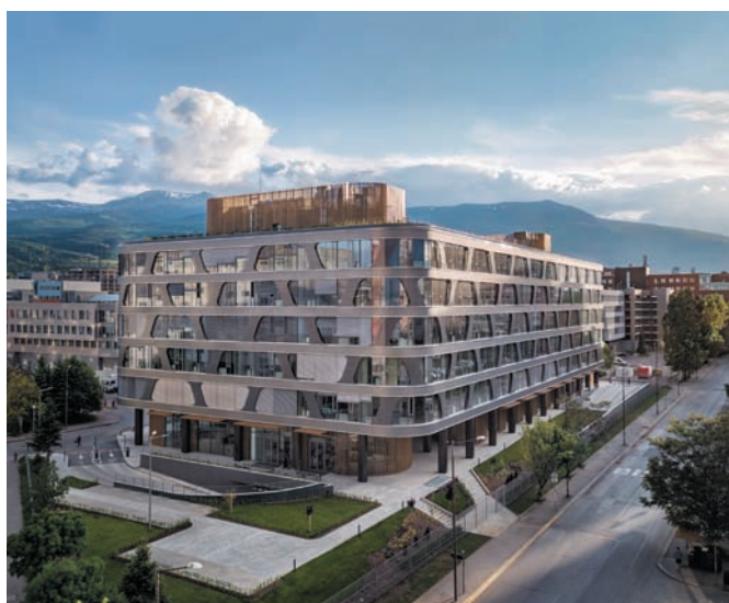
Рис. 22. Офисное здание «Бизнес-Парк». София. A&A architects. 2017–2019 годы (источник: aaa.bg)
