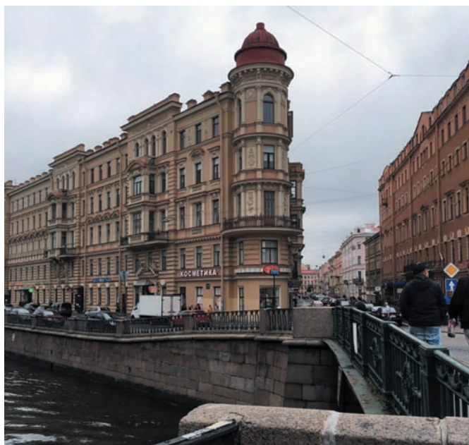
Рис. 4. Вид со стороны Кокушкина моста (на переднем плане) в сторону Столярного переулка. Слева – доходный дом В.А. Ротьева-Рожнова. Архитектор П.Ю. Сюзор. 1886–1888 годы; справа – дом, где жил Н.В. Гоголь. Фото из открытых источников интернета
