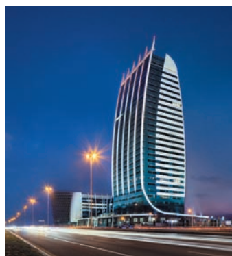
Рис. 3. Офисная башня «Столичный Форт». София. A&A architects. 2008–2015 годы (источник: a.a.bg). Фото А. Эмилова
