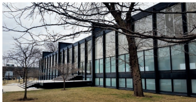
Рис. 2. Краун Холл – корпус колледжа архитектуры и дизайна Иллинойского технологического института (источник: [1])
