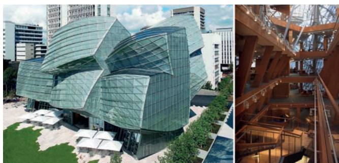
Рис. 15. Здание штаб-квартиры и кадрового отдела компании «Новартис» (источники: https://www.archdaily.com , проект «International 33/34. Kamnyc Novartis» – https://novate.ru/blogs/190415/30900/ )
