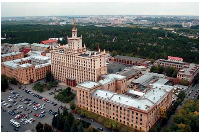
Рис. 6. Главное здание Южно-Уральского федерального университета (ЮУрГУ). Челябинск. 1954–1960 годы. Архитектор С. Истомин
