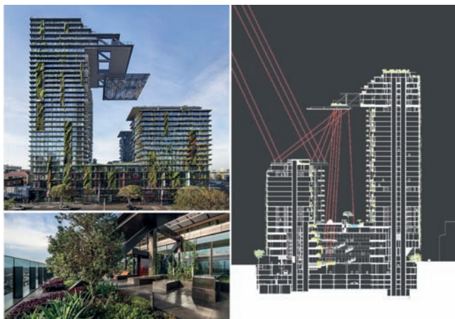
Рис. 14. Многофункциональный комплекс «One Central Park». Сидней: общий вид, зелёная терраса жилого здания, схема пассивных приёмов освещения атриума
